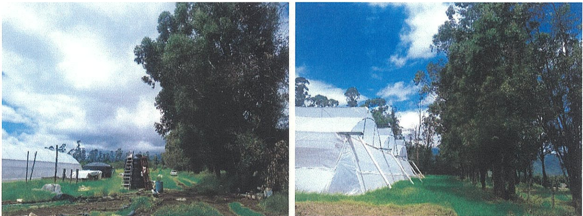
Imagen 3.- Proximidad de arbolado a la nave de invernadero y el riesgo de daño.
