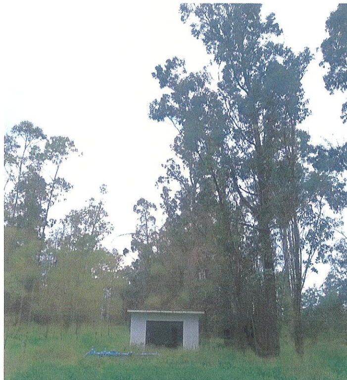
Imagen 4.- Proximidad de arbolado a la nave de invernadero y el riesgo de daño.
